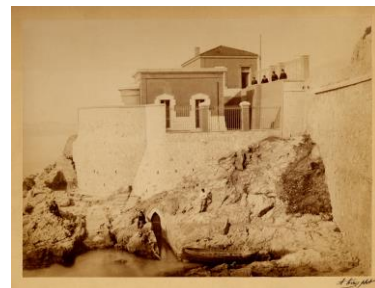
Bâtiments du marégraphe en 1883
