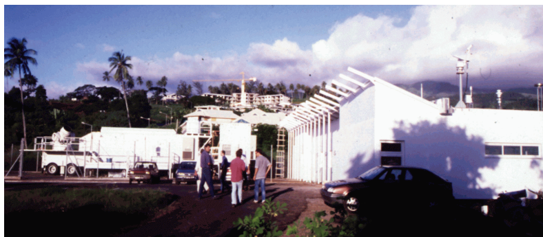
Site de l'Observatoire Géodésique de Tahiti, à Punaauia.
