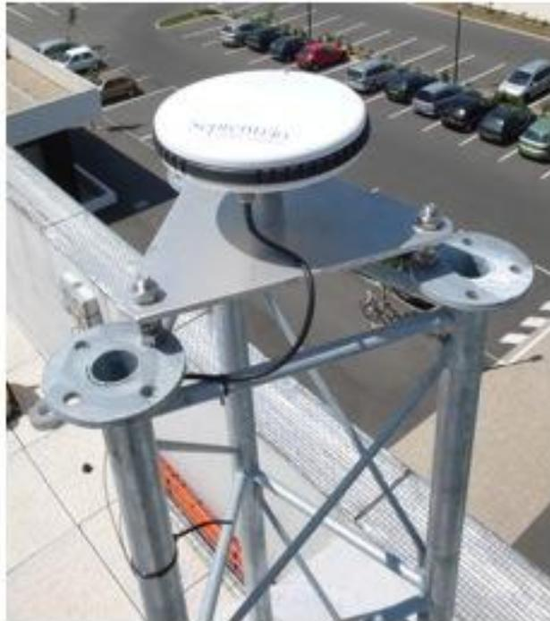
*Figure 2 : Station installée sur le bâtiment ILE*
