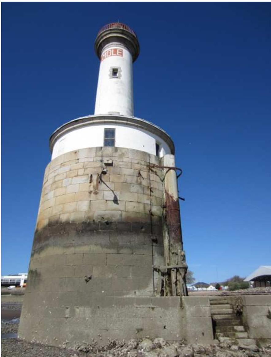
**Figure 18 : Restes du puits de tranquillisation à l'extrémité de la jetée du vieux-môle de Saint-Nazaire (Avril 2014).**
