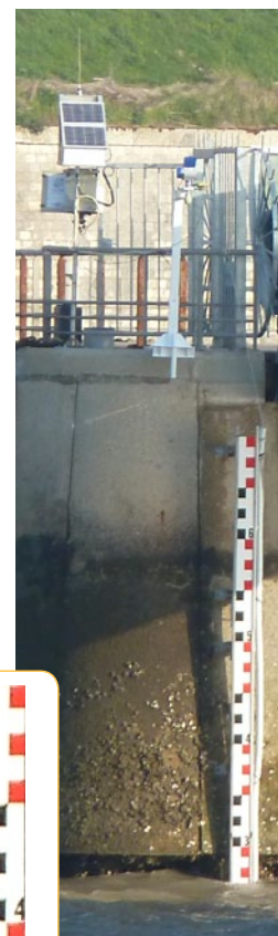
Exemple de réalisation d'échelle de marée. Les carrés, de couleur rouge ou noire, ont 10 centimètres de côté.
