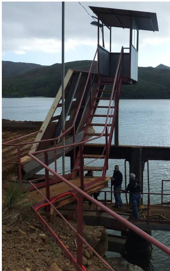
*Guérite pour installer l'antenne Yagi et les panneaux solaires*
