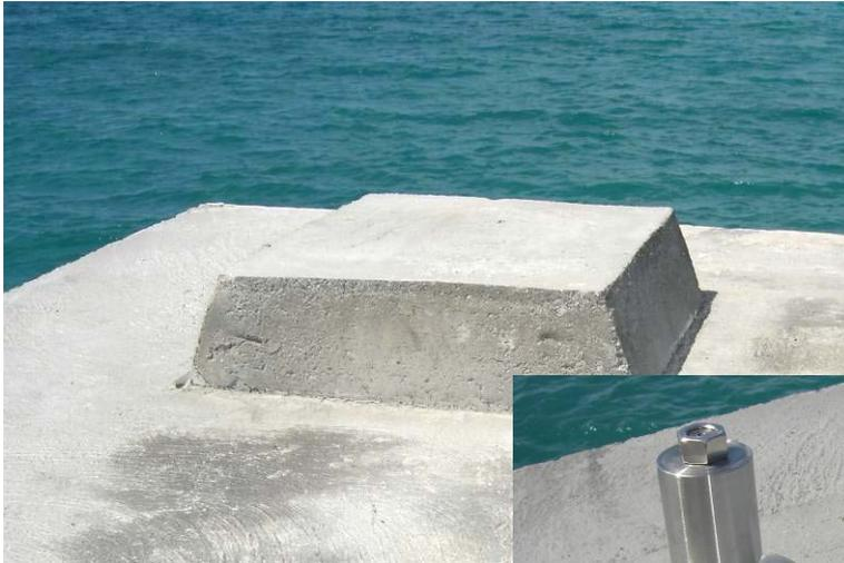
Pile GNSS dans l'angle du local. En béton armé, elle est intimement liée au sol et aux murs de la station.
