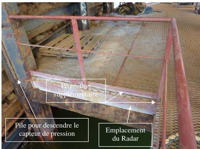
Pour le capteur de pression, la pile du wharf permettra de faire courir aisément le câble ventilé.
