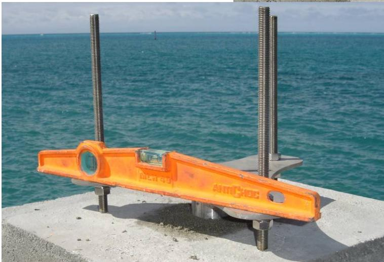
Nivellement sur les trois axes support. Ajustement à l'aide des vis. Opération à réaliser avant, pendant et après la mise en place de mortier chimique (temps de prise suffisamment long).
