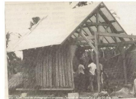
"La structure en bois est offerte par la S.I.M. Légère et peu coûteuse, elle est adaptable aux besoins des sinistrés. Ce sont eux qui vont monter les murs et poser la toiture. Cette case peut être agrandie par derrière. Quelques jours après les fondations, elle est habitable."
